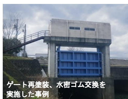
図- 1.19 河川構造物の老朽化対策
