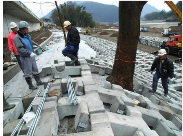
高木を保全する護岸工法の試行
