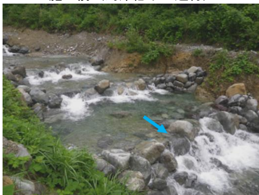
施工後（出水後）
