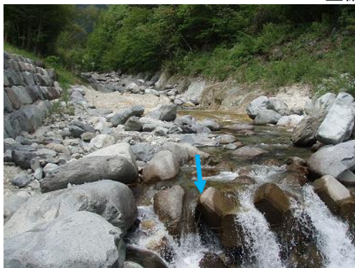
施工前（河床低下の進行）
