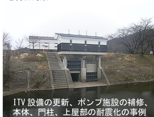
図- 1.27 上戸排水機場の老朽化対策・耐震化
