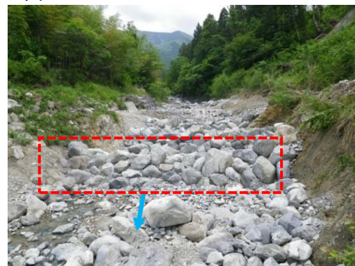
施工直後（石組み落差工）
