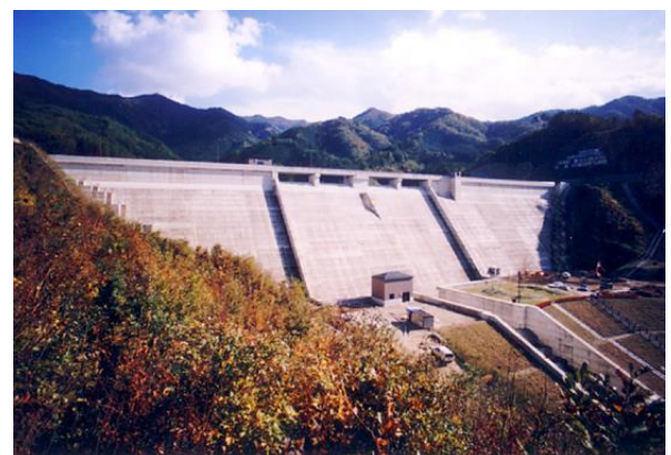
図- 1.15 大ヶ洞ダム
