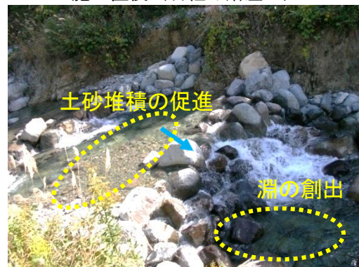
施工後（5ヶ月後）
