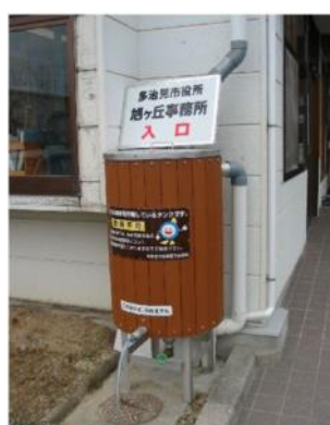
貯留・浸透施設の設置
