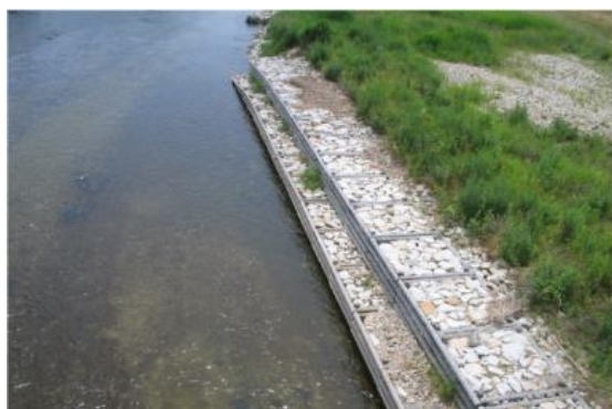
図- 2.7 木工沈床の整備
