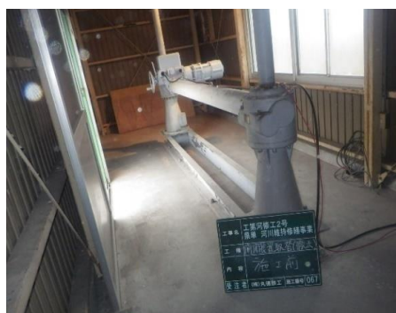
図- 1.7 前の川逆水樋門の老朽化対策（左 修繕前、右 H29 修繕後）
