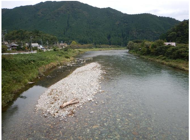
下洞戸橋下流
