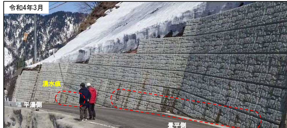
切土補強壁面下部の排水管から湧水痕が確認される
