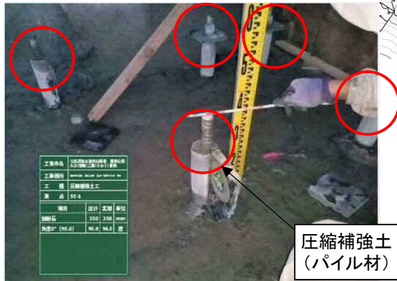
(圧縮補強土の施工状況)
