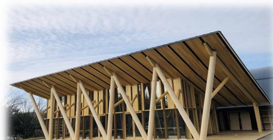
【森林総合教育センター 木造平屋建て 約129m 2 】
