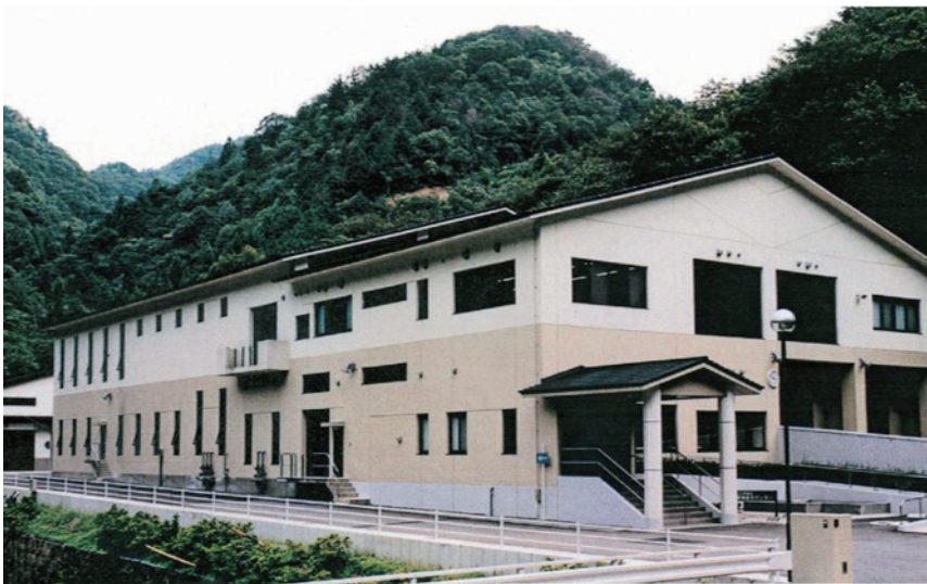
郡上市環境衛生センター外観
