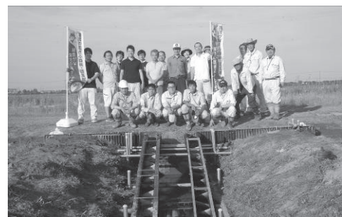
水田魚道の設置
