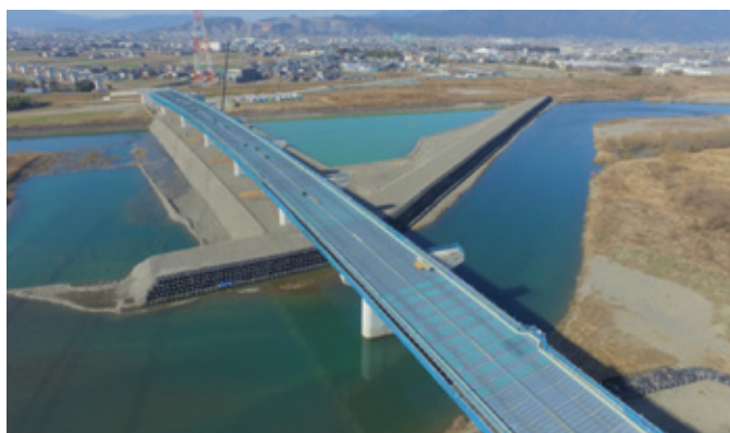
東海環状自動車道西回り区間【H29.3撮影】揖斐川左岸から大垣西IC方面を望む
