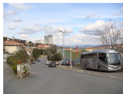
発電所の冷却塔が立ち並ぶ③
