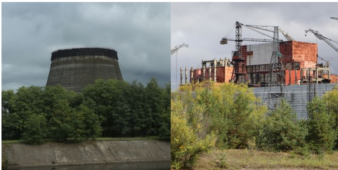
左：建設途中だった原発冷却塔。 右：建設途中だったチェルノブイリ原発5号炉。
