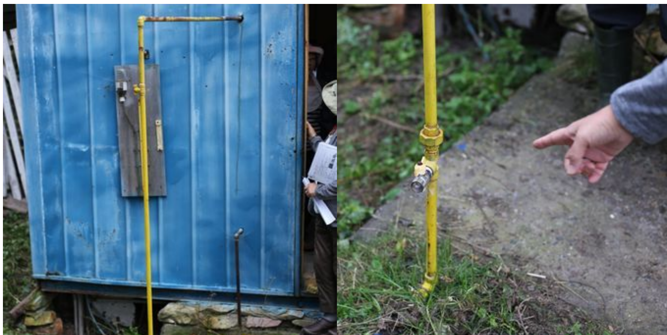
左：施設建物の外部。 右：ガスが作られていることを、火を着けて確認。
