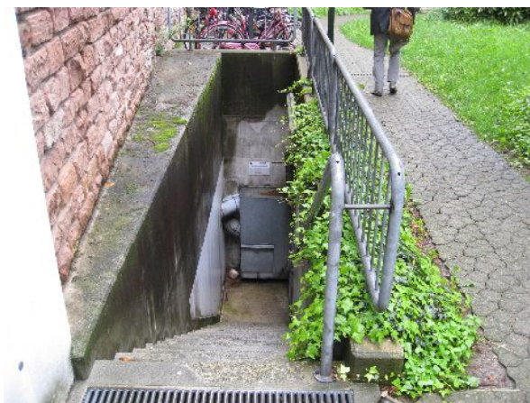
中庭から共同地下駐車場へ
