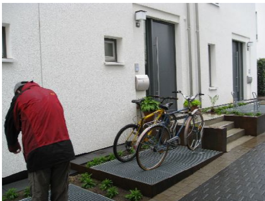
自転車が置いてある場所は、地下に通じる駐車場等の通気口になっている。
