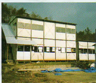
下有知現場整理所の全景
