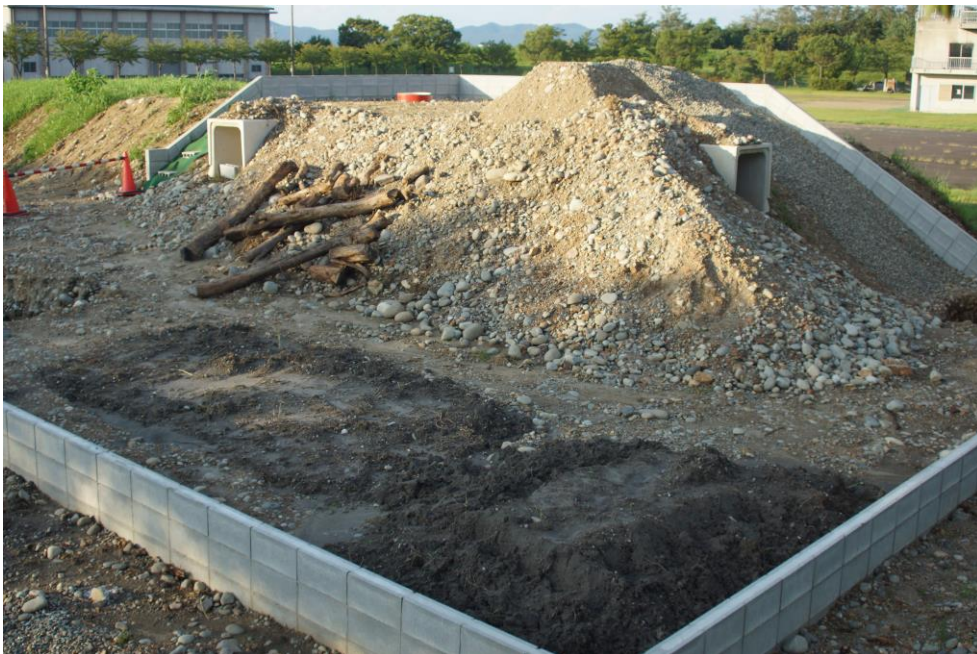
南西側より全体を撮影
