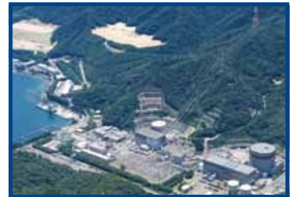
日本原子力発電株式会社 敦賀発電所 ※
