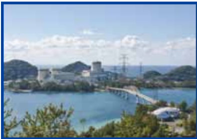
関西電力株式会社美浜発電所 ※
