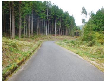
▲道路景観整備事業で明るくなった道
