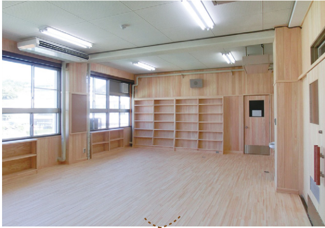
内装木質化した図書室
