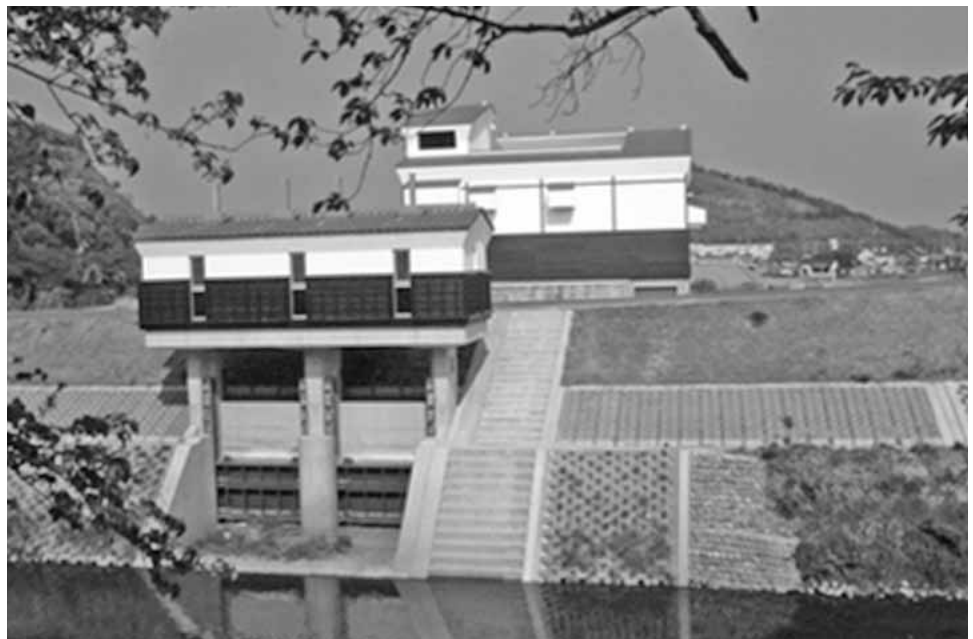
上戸排水機場 (各務原市)
