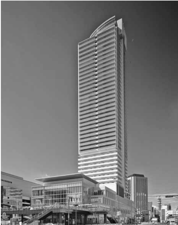
岐阜シティ・タワー (岐阜市)
