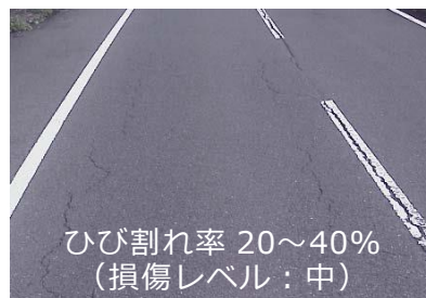
写真 5-1 ひび割れ率と舗装の状態
