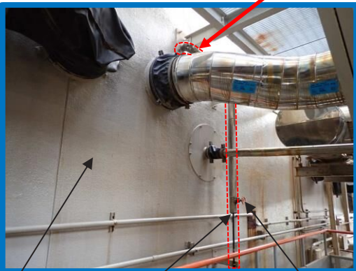
タービン建屋(壁面)
