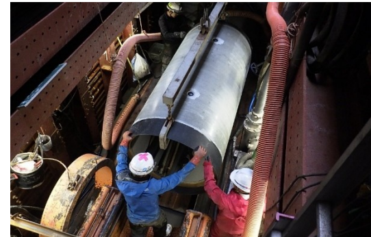
非開削工法：道路を地表から掘らず に管を設置します
