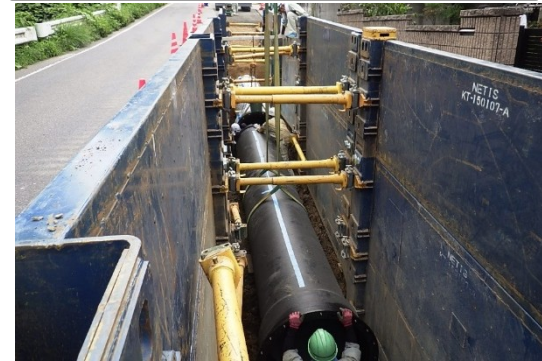
開削工法：道路を掘って 管を設置します
