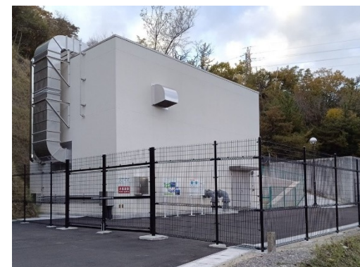
肥田緊急時増圧ポンプ場 (令和6年度完成)
