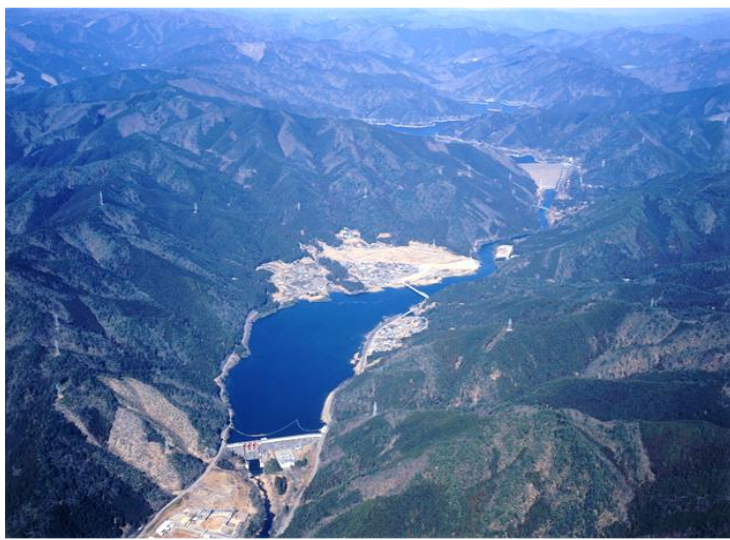
【岩屋ダム】 馬瀬川(下呂市)
