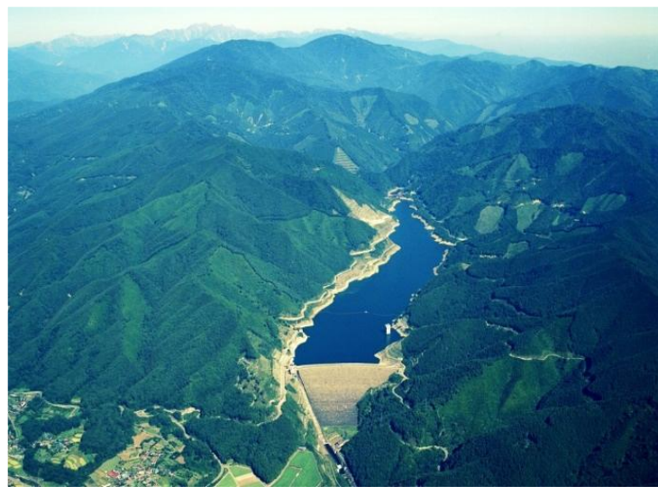
【味噌川ダム】 木曾川(長野県木祖村)
