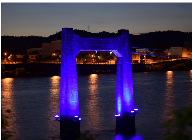
旧山川橋主塔（川辺町）
