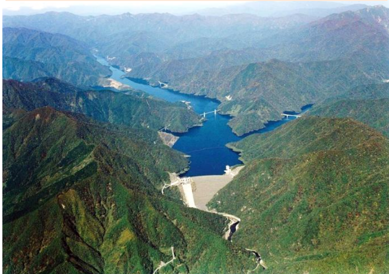
【徳山ダム】 揖斐川(揖斐川町)
