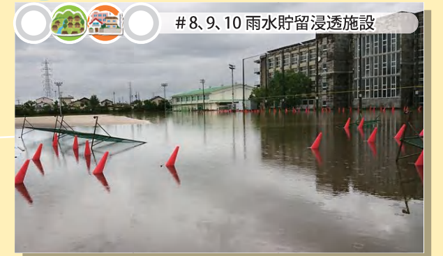
校庭に雨水貯留浸透施設を整備(大垣市)
