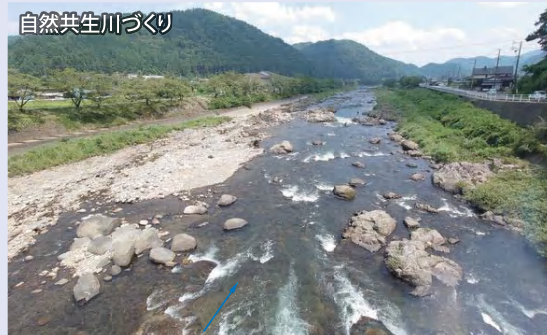
自然共生工法 分散型落差工（長良川・郡上市）
