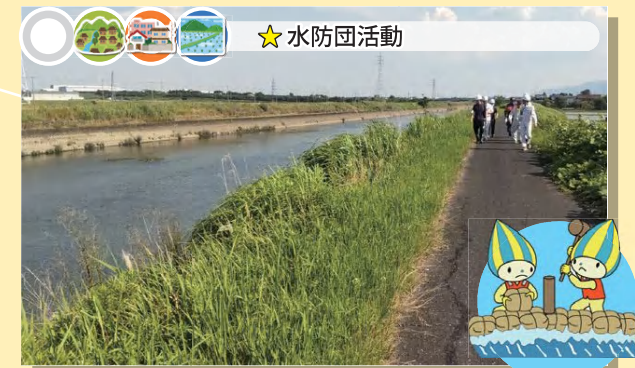
重要水防箇所における合同巡視の実施(水門川・大垣市)
