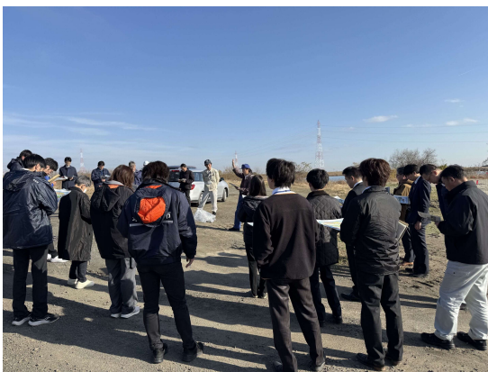
しゅんせつ工事箇所での様子
