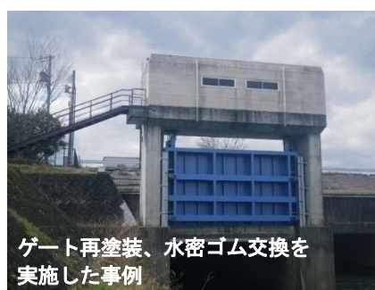
図- 1.22 河川構造物の老朽化対策
