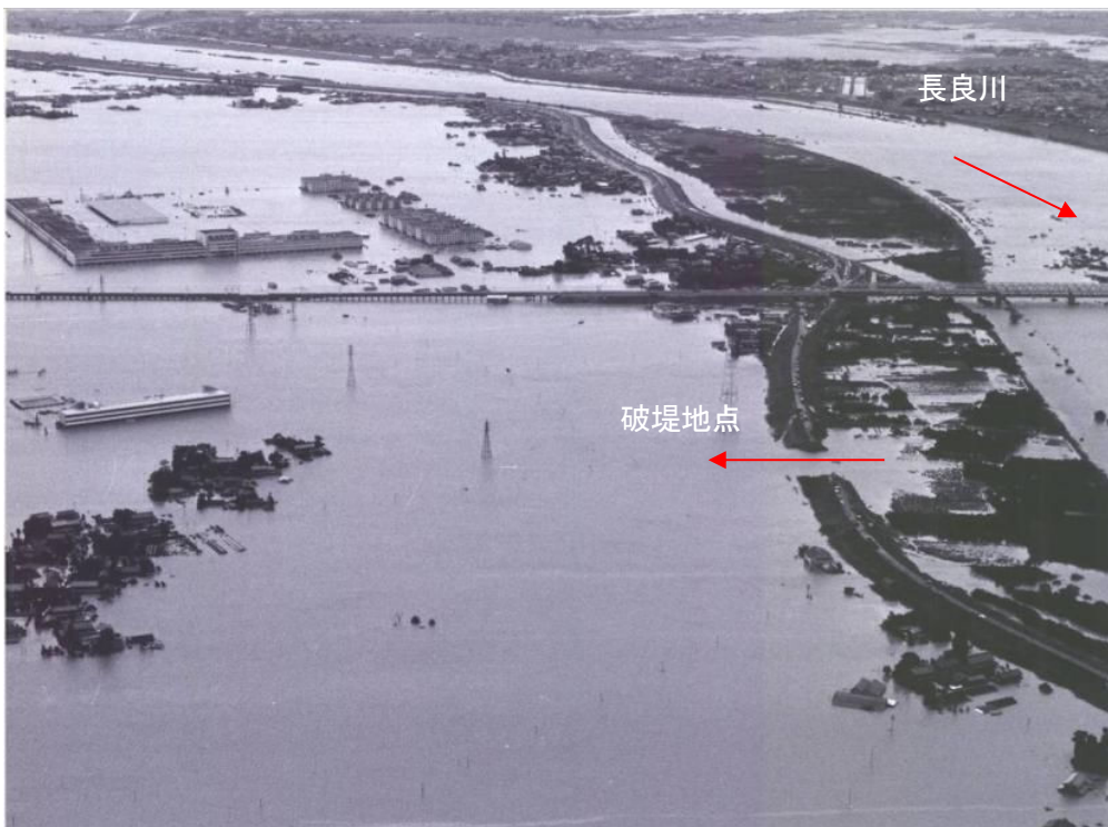
長良川 安八町大森 長良川右岸の破堤状況 図- 1.5 昭和51年9月洪水浸水状況写真
