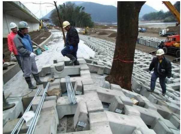
高木を保全する護岸工法の試行
