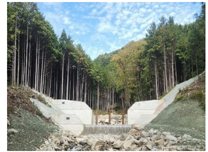
<流木等を捕捉する スリット型治山えん堤の整備>
