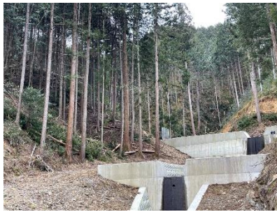
<間伐と治山施設を組み合わせ 森林の整備>
