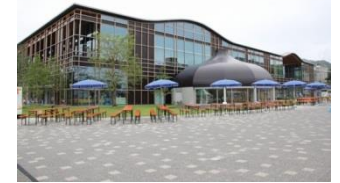
地中熱HP (ぎふメディアコスモス)
