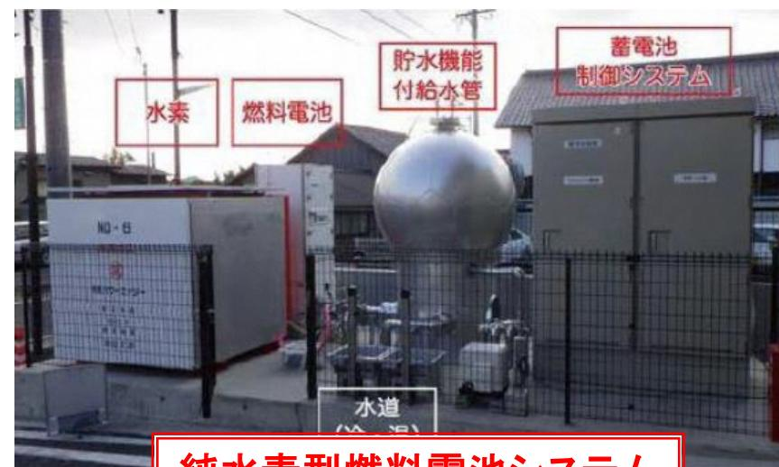
純水素型燃料電池システム
