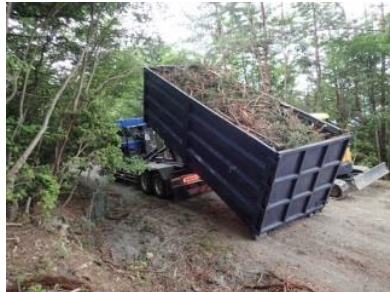
(未利用端材等の運搬)
