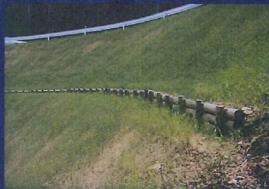
盛土小段への木柵工
