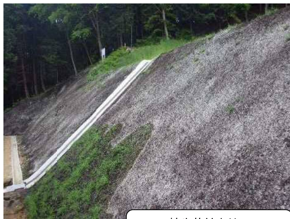
植生基材吹付工 別現場における施工事例
