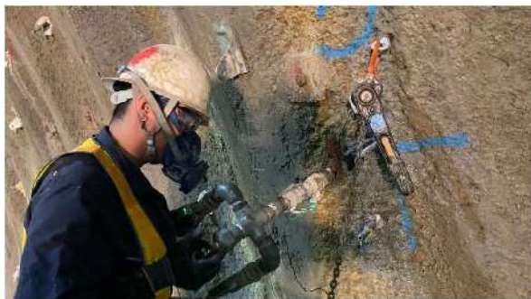
注入準備作業
