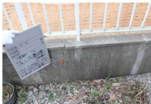
工事後の調査
