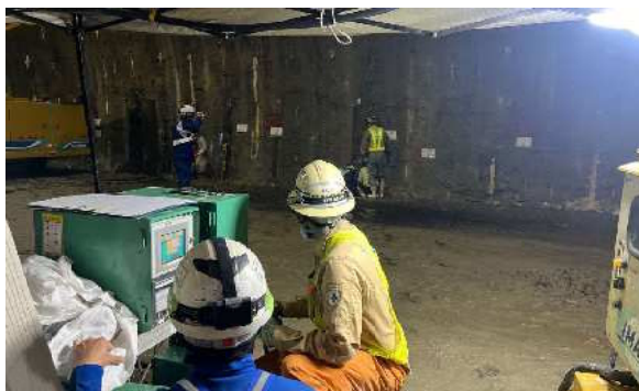
注入作業中における確認
