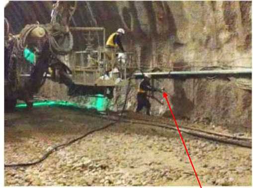
挿入した鋼管から薬液を注入
