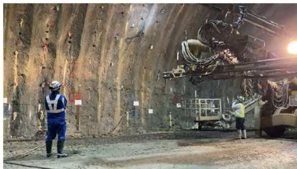
注入作業中の漏出確認
