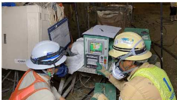
注入量と圧力値の確認
