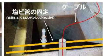
塩ビ管 （スリット加工）
