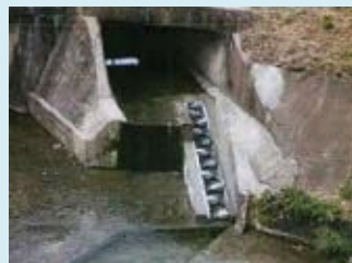
9-③ 用排水路・河川落差解消後
