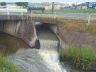
9-③ 用排水路・河川落差解消前
