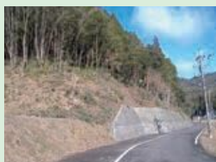
2-② バッファーズーン整備後
