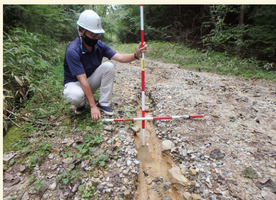
路面水により上置き路盤が洗掘され、基面のマサ土が露出している状況
