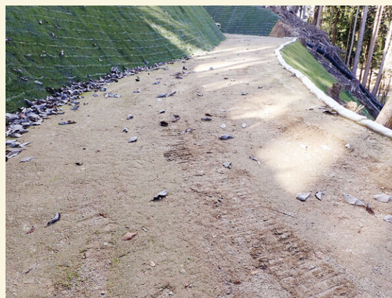
セメント安定処理施工後 6ヶ月経過
