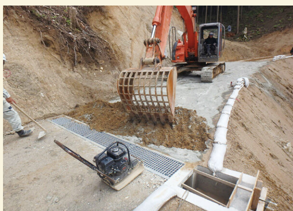
散布された固化材をスケルトンバケットにより攪拌する様子
