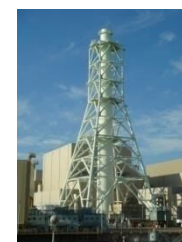
排気筒改造工事
