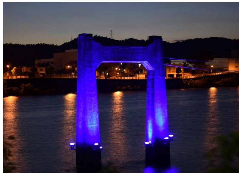
旧 山川橋主塔（川辺町）
