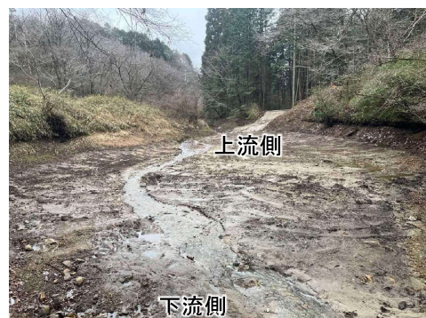
神田川堰堤付近浚渫後の状況(3/25)
