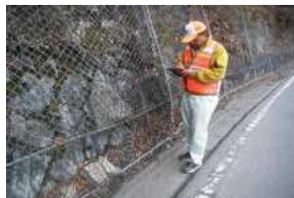
MSによる法面点検状況
