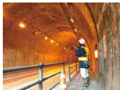
初期調査や緊急点検ではMEを活用し点検を実施
