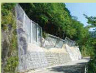
対策事例：落石防止柵の設置
