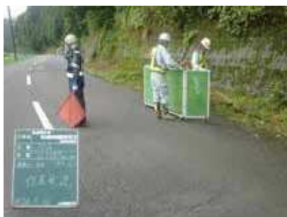
除草作業状況
