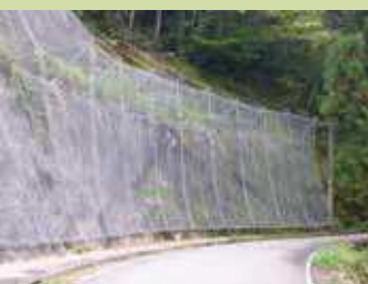
対策事例：落石防護網の設置
