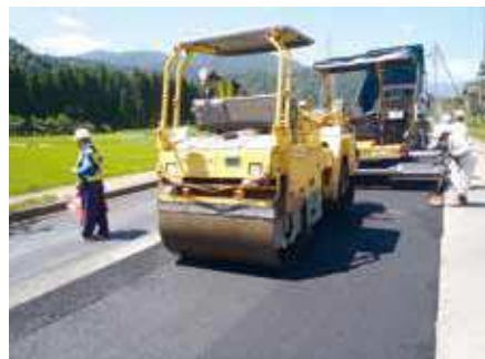
舗装補修状況
