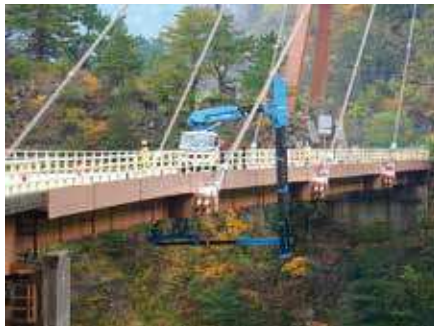
橋梁点検状況
