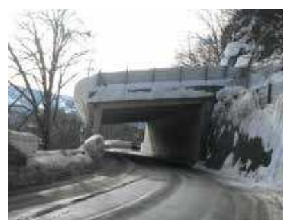
スノーシェッドによる冬期交通の確保
