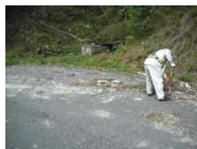
路面等清掃状況
