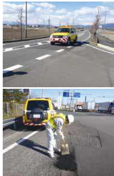
道路パトロール状況
