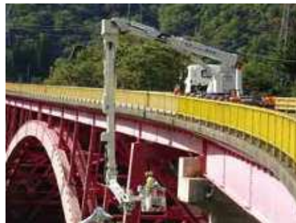
橋梁補修状況
