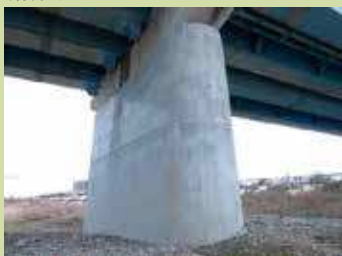
対策事例：橋脚の補強
