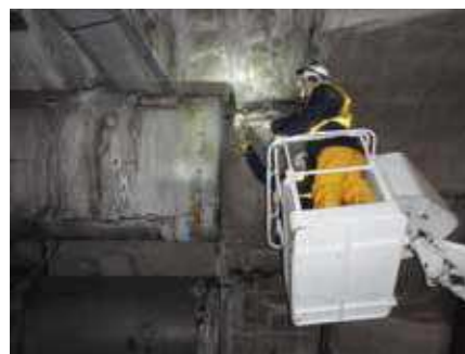
トンネル点検状況
