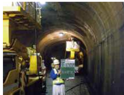
トンネル補修状況
