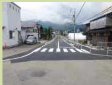
対策事例：歩道整備による安全な歩行空間の確保
