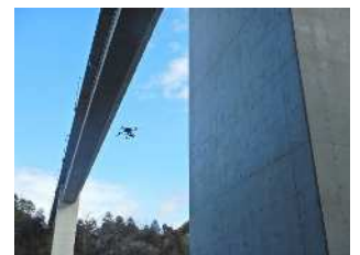
ドローンによる橋梁の点検状況
