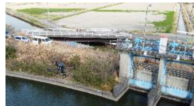
ドローンによる点検事例
