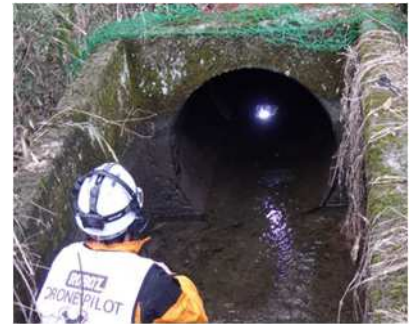
狭小空間用ドローンによる農業用水路内の点検
