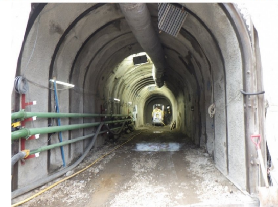
排水トンネル掘削
