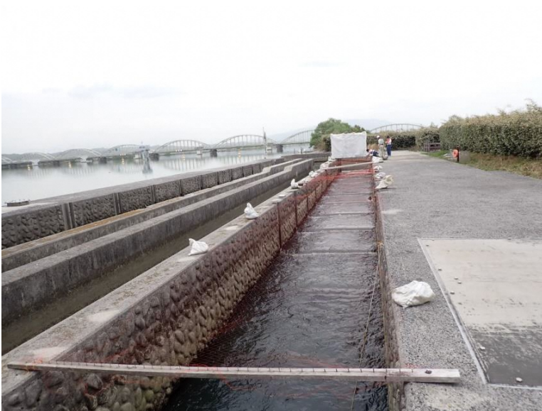
呼び水式魚道への防鳥ネットの設置状況 （令和6年4月）
