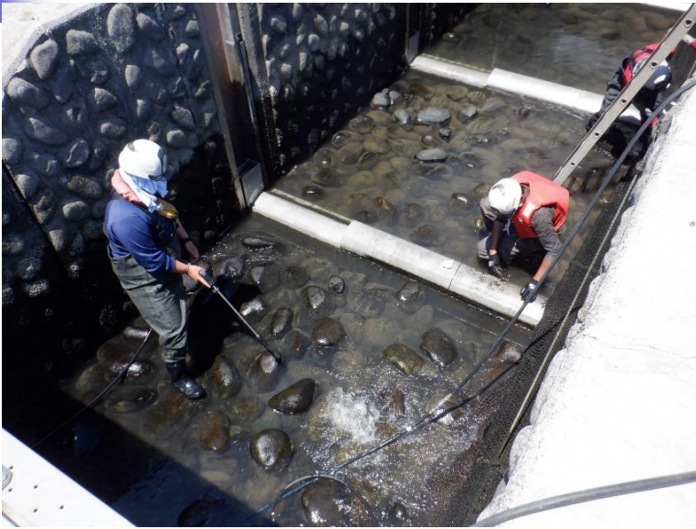
左岸呼び水式魚道の清掃状況 （令和6年6月）
