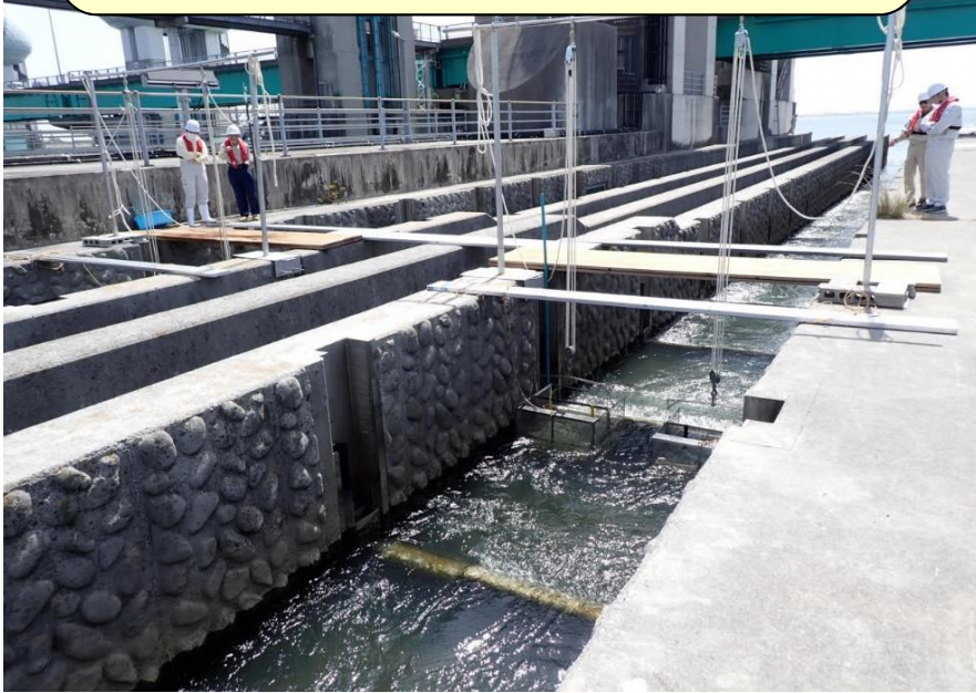
右岸呼び水式魚道での稚アユ捕獲状況（令和6年4月）
