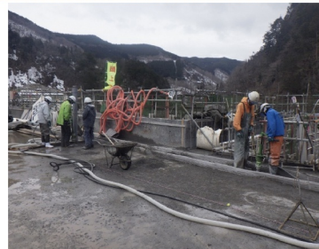
越冬面チッピング(人力施工)
