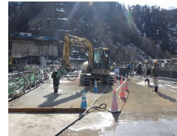
越冬面チッピング(機械施工)
