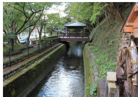
曾代用水 川湊公園（美濃市）
