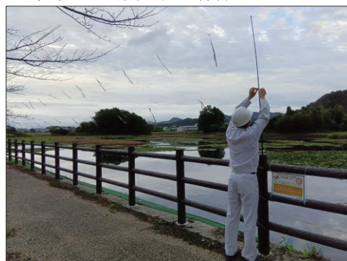
ため池の鳥よけ設置作業
