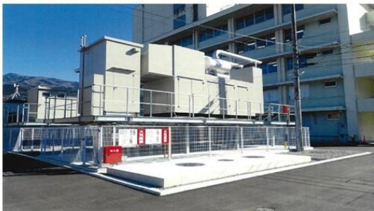
非常用発電装置等の改修工事（下呂総合庁舎）
