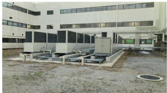
空調設備の更新工事（福祉・農業会館）
