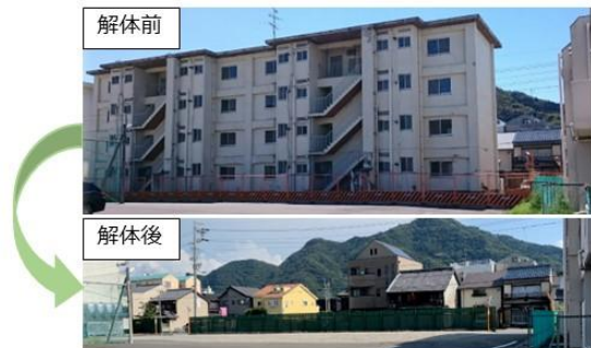
集約化により解体 （長良第1県職員アパート）
