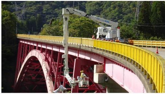
橋梁の点検（成出橋）
