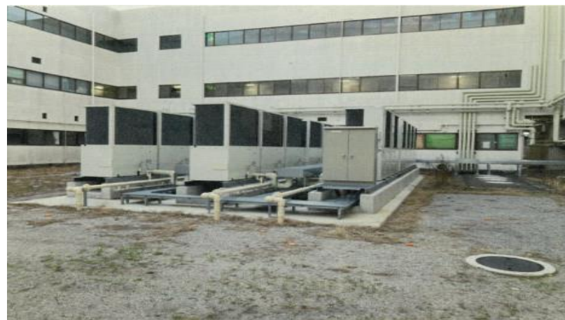
空調設備の更新工事（福祉・農業会館）
