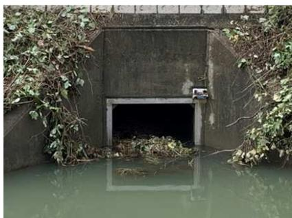
写真 5-19 大谷川右岸樋管ゲート脱落状況
