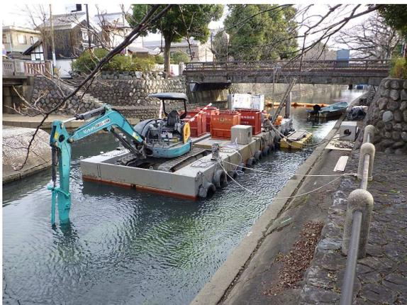
写真5-5 河道掘削施工状況
