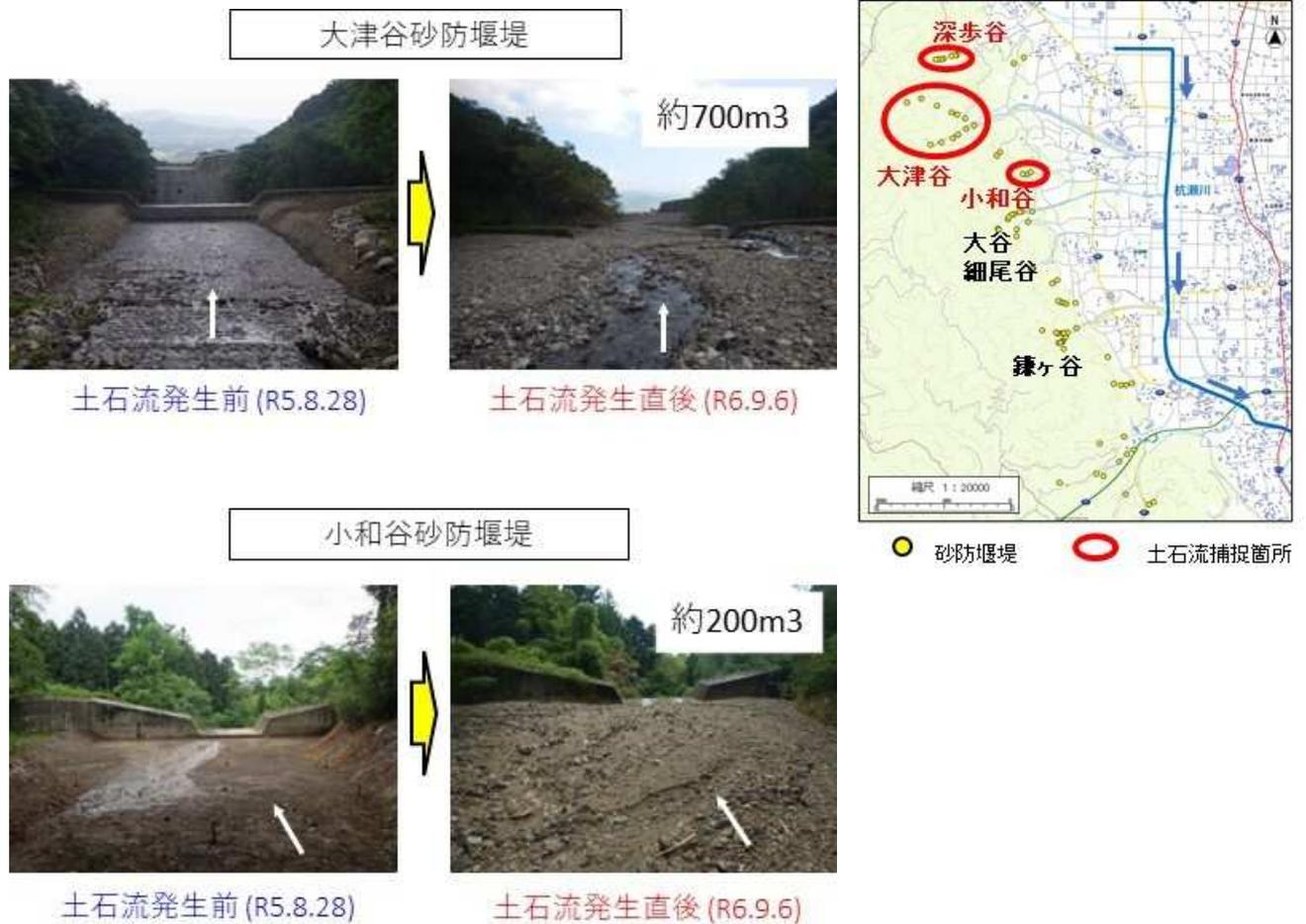
図 5-9 土石流捕捉状況
