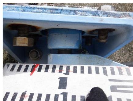
写真 5-21 他の樋管において点検時に確認されたマイターゲートのヒンジ部ボルト破損事例
