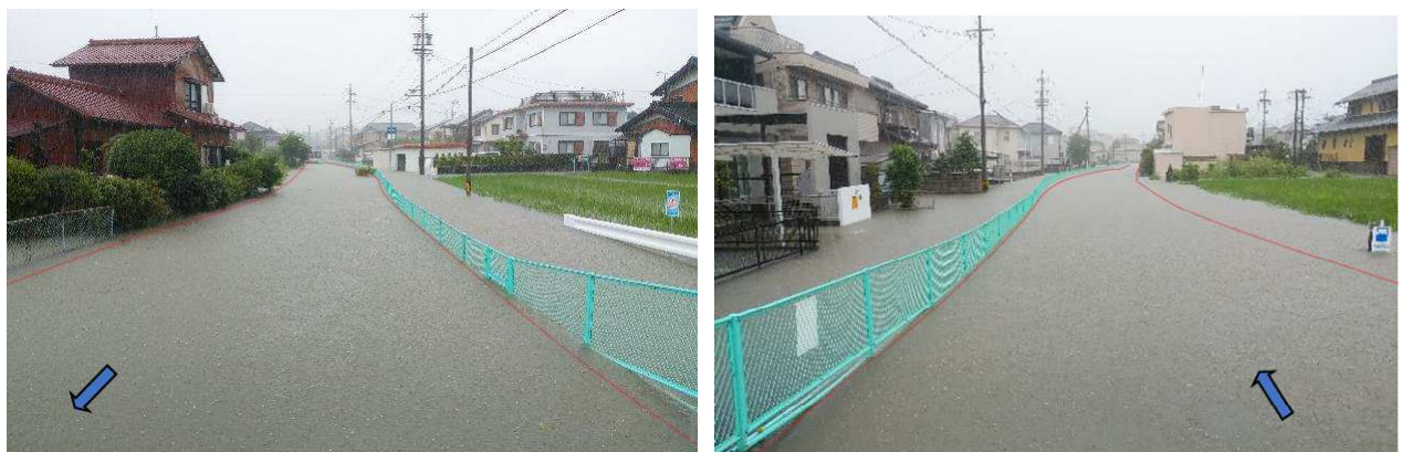
写真 4-2 水門川（八島町付近）の浸水状況
